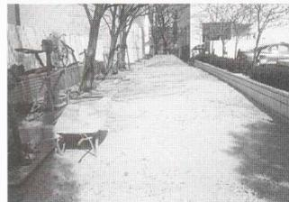
写真-19 路盤整正状況
