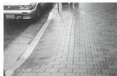
写真-24 車両乗入れ部の納まり(縁切り施工)
