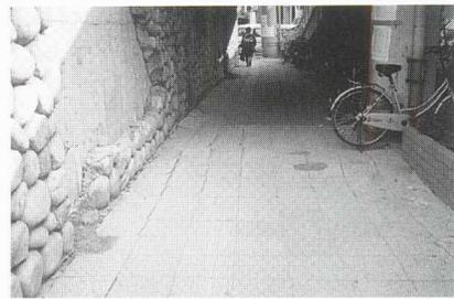
写真-15 地盤沈下と段差
