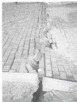
写真-4 陥没
